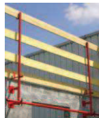
Garde-corps provisoire en bois
