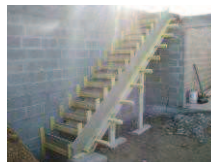
Coffrage bois pour escalier en béton
