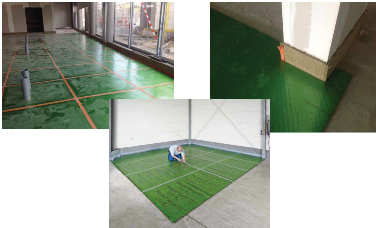
Figure 8 – Illustrations de pose de Regupol : les lés sont précisément disposés bord à bord et ensuite scotchés. La chape coulée par-dessus ne pourra pas couler entre les lés.
