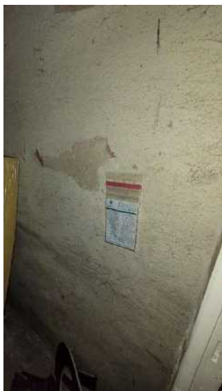
Placard sous escalier 01 : PA21 Non Amiante
