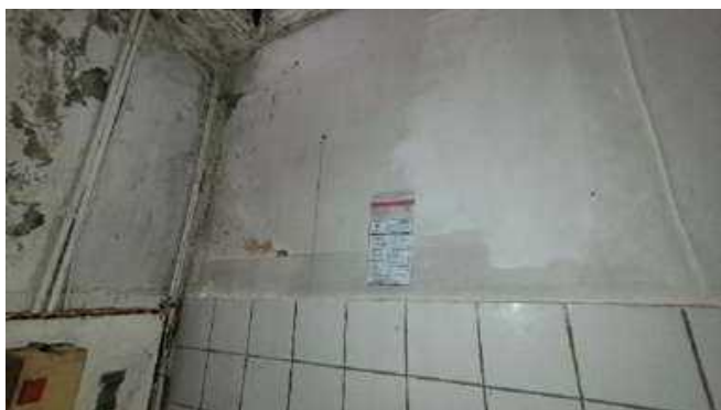
Plonge : PA19 Non Amiante
