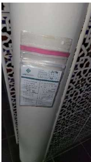
Salle de restaurant 03 : PA07 Non Amiante
