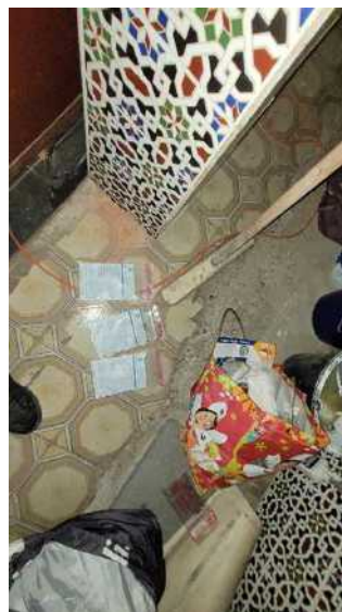
Degagement 02 : PA22/23/26 Non Amiante
