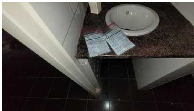
Wc 02 : PA08/09 Non Amiante
