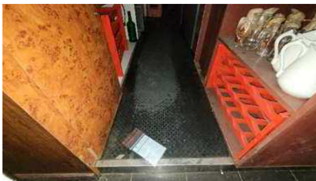
Salle de restaurant 01 : PA30 Non Amiante
