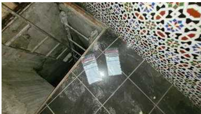
Salle de restaurant 02 : PA01/02 Non Amiante
