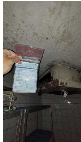
Chambre Froide : PA16 Non Amiante
