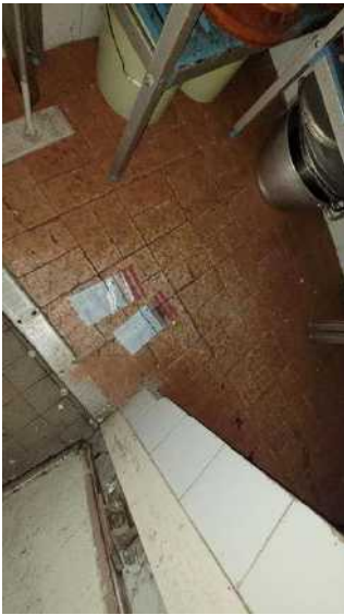
Chambre Froide : PA14/15 Non Amiante
