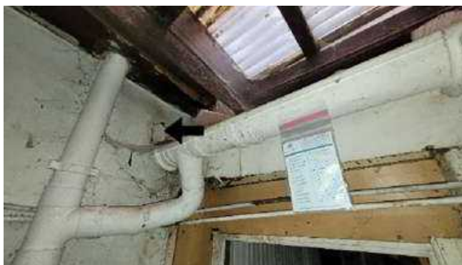
Plonge : PA20 Non Amiante
