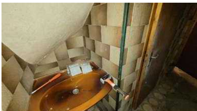
Wc 03 : PA24/25 Non Amiante
