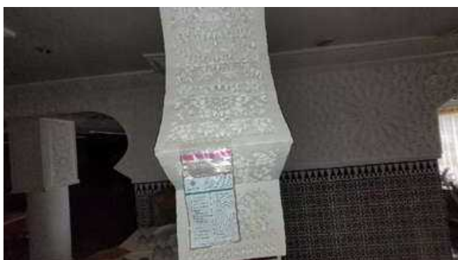
Salle de restaurant 02 : PA05 Non Amiante
