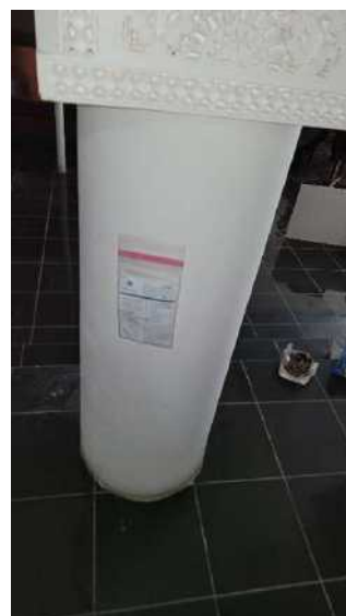
Salle de restaurant 01 : PA06 Non Amiante
