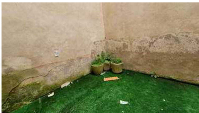
Cours : PA29 Non Amiante
