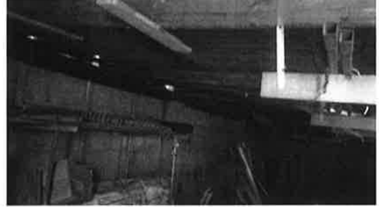
11 Local stockage attenant \ Réf: R1 Toiture plaques ondulées fibre ciment
