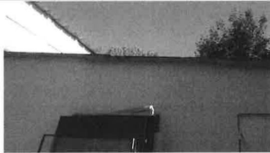
11 Local stockage attenant \ Réf: R1 Toiture plaques ondulées fibre ciment
